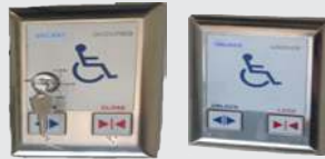
Disabled Toilet Door Controller
